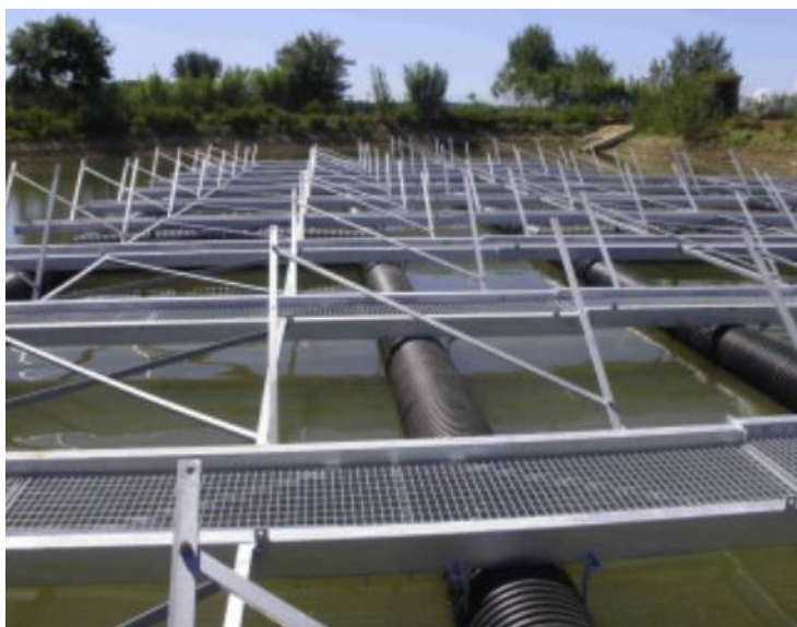
Gambar 36 Contoh sistem panel surya terapung kelas 1 [33].
