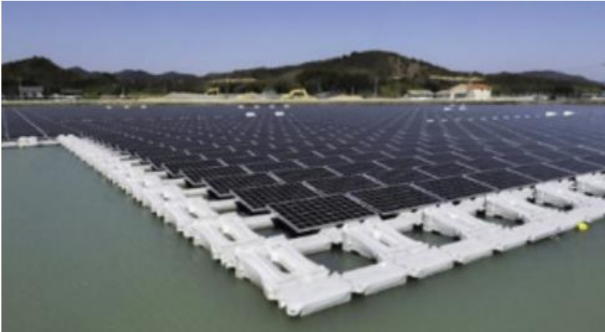
Gambar 37 Contoh sistem panel surya terapung kelas 2 [33].
