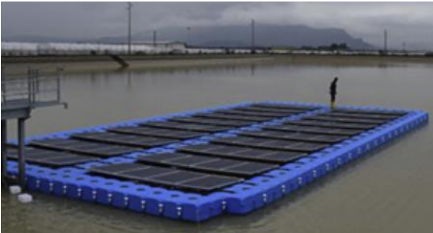
Gambar 38 Contoh sistem panel surya terapung kelas 3 [33].
