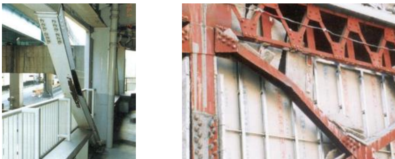
Gambar 22 Tekuk pada elemen [19]
