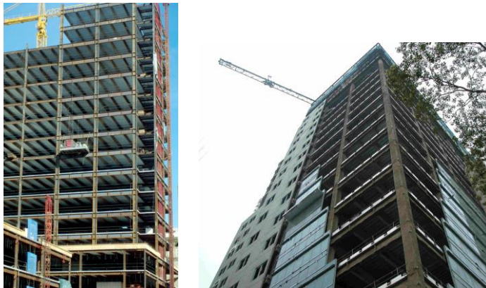
Gambar 30 Sistem rangka pemikul momen khusus ( special moment frame ) [19]
