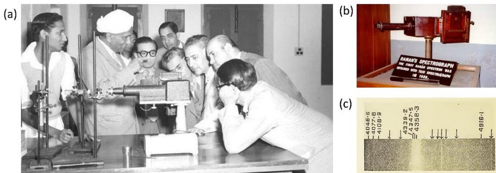
**Gambar 24** (a) C. V. Raman mendemonstrasikan alat spektrograf yang digunakan dalam mengamati proses hamburan Raman (Indiatimes, 2021), (b) spektrograf yang digunakan C. V. Raman dan K. S. Krishnan dalam mengamati hamburan Raman, (c) spektrum garis pada plat foto yang menggambarkan hamburan Raman (Raman dan Krishnan, 1928).
