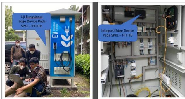
Gambar 2.13 Integrasi SPKL menggunakan *edge-device*
