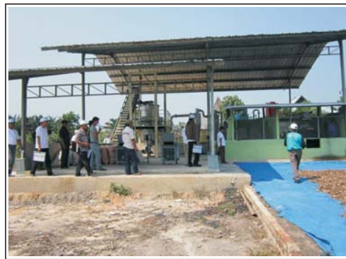
Gambar 21 PLTD 100 kW untuk pedesaan BBG dari proses gasifikasi tandan kelapa sawit [14]
