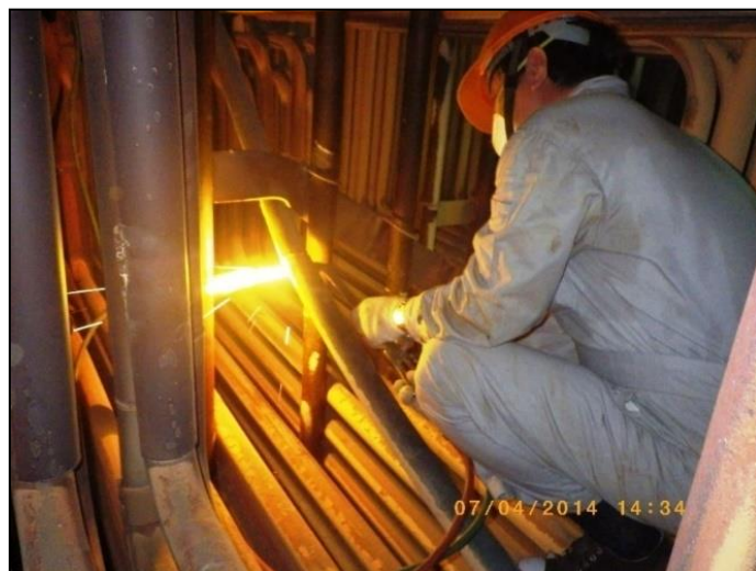
Gambar 5. Pemotongan pipa yang gagal menggunakan torch
