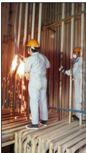
Gambar 5. Pemotongan pipa yang gagal menggunakan torch
