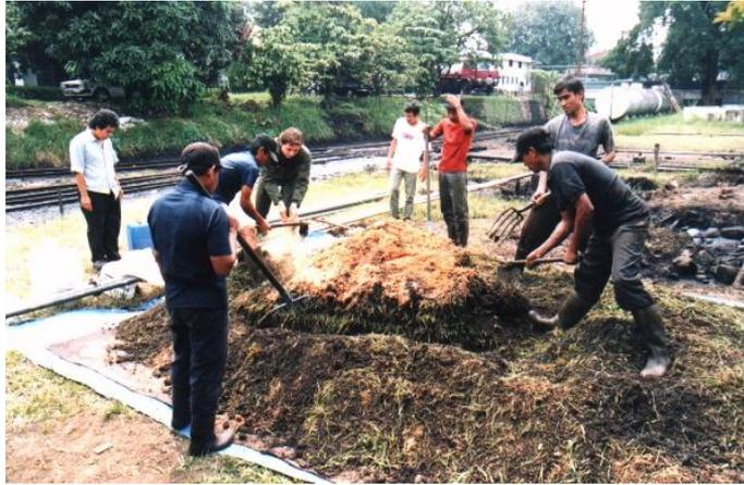
**Gambar 10.** *Biopile* skala pilot di area Daop 2 PT KAI. Dokumentasi *workshop* bioremediasi, PAU Bioteknologi, 1997.
