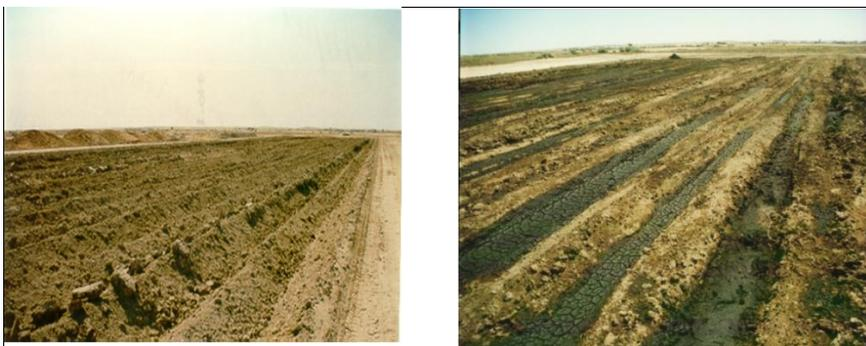
**Gambar 12.** Teknik bioremediasi *wind row*. Foto adalah courtesy dari Dr. Mc NiClure (Flinders University).
