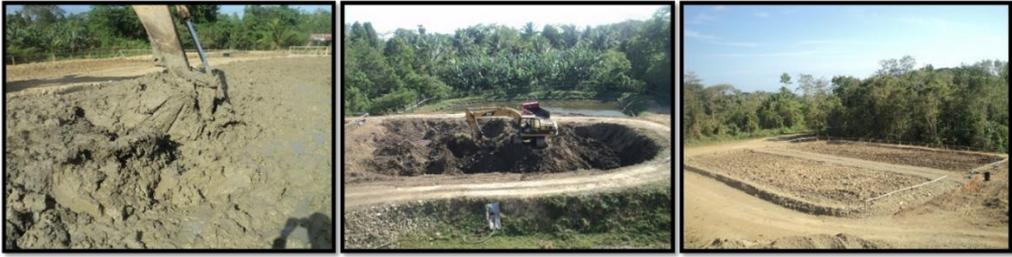
**Gambar 18.** Proses *on-site bioremediation*: pengadukan, penambahan *bulking agent*, pengadukan tahap operasional (E. Kardena\*)
