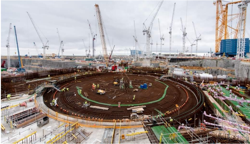
Gambar 105 Selama proses konstruksi pada Reaktor Besar dan Modern, ribuan Perkan dibutuhkan. Pada PLTN Hinkley Point C, di butuhkan 8000 Pekerja on-site selama puncak pembangunan (World Nuclear Association, 2022b)
