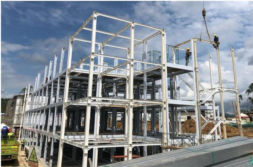
**Gambar 10** *Konstruksi modular hunian pekerja konstruksi IKN*
