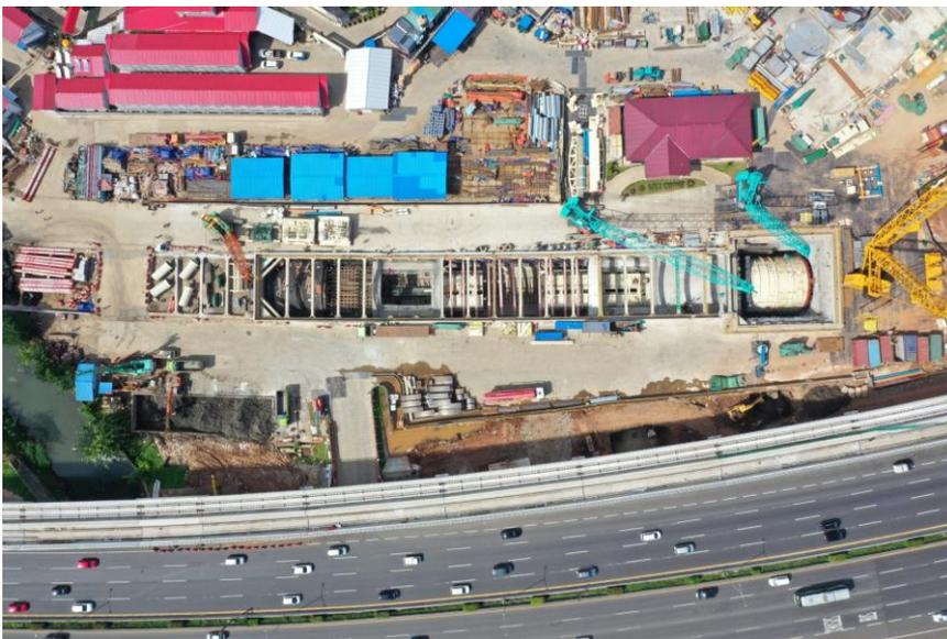
**Gambar 9** Instalasi TBM terowongan no. 1 pada proyek Kereta Cepat Jakarta Bandung (sumber: KCIC)
