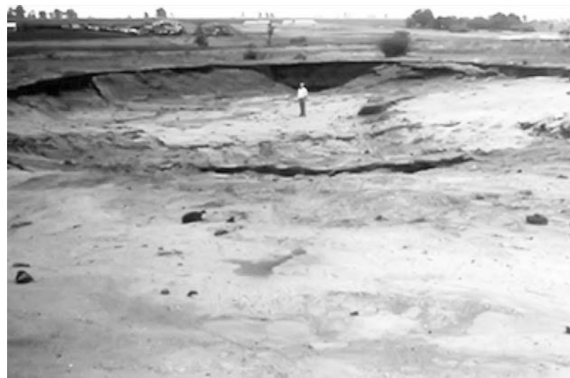
Gambar 9. Penurunan permukaan tanah akibat keruntuhan pilar tambang bawah tanah di Sasolburg, South Africa (foto disumbangkan oleh Prof. N.v.d. Merwe, University of Pretoria)
