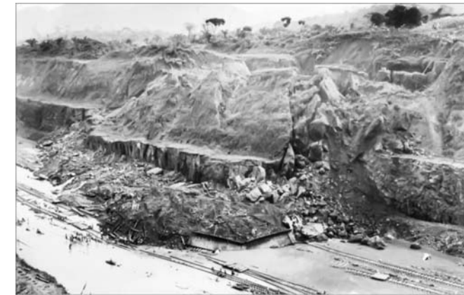
Gambar 1. Contoh longsor yang terjadi pada tanggal 21 Agustus 1912 dalam pekerjaan konstruksi terusan Panama (Rogers, 2011)
