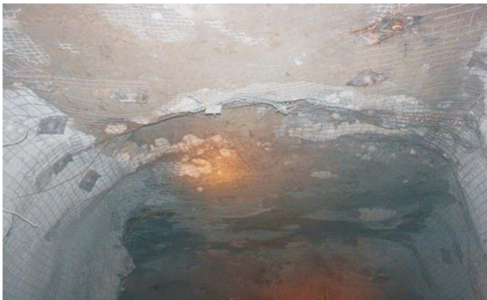
Gambar 4.17 Stopping dibawah pastefill yang diperkuat setelah 28 hari (Sulistianto, et.al, 2013b)
