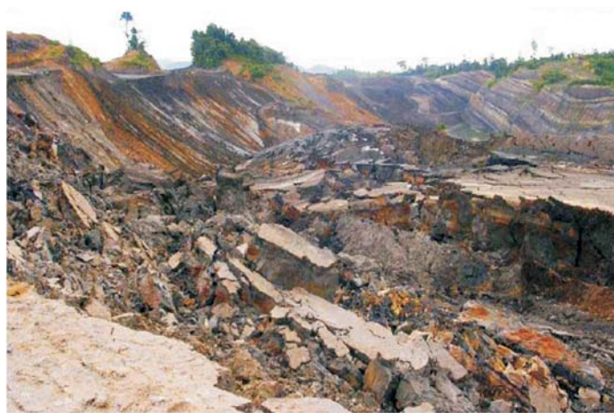
Gambar 3.6. Longsoran Yang Terjadi Pada Low wall Tambang (Sulistianto, et.al, 2007c)
