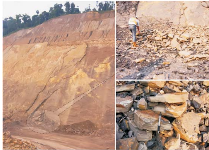
Gambar 3.13 Jenis longsoran pada low-wall dengan perlapisan tipis
