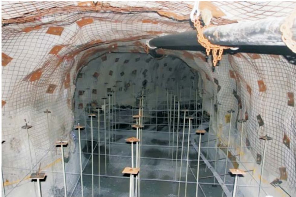
Gambar 4.16 Pemasangan material perkuatan untuk pastefill (Sulistianto, et.al, 2013b)
