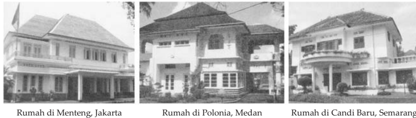
Gambar 1.1.: Rumah Tembok Konsep Villa Eropa (Sumber: Leushuis, 2014)
