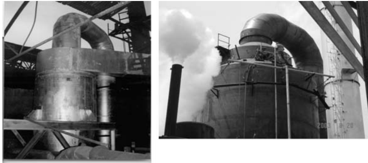
Gambar 21: Design Cyclone dan Wet Scrubber untuk Industri Gula
