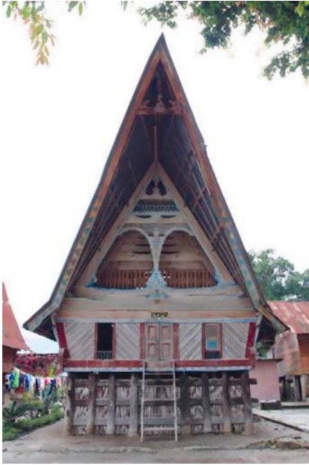
Gambar 6. Struktur Kepala-Badan-Kaki pada Rumah Batak Toba
